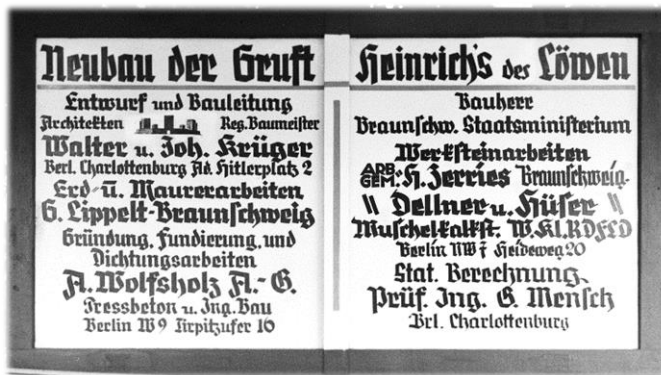
Firmenschild auf der Baustelle zum Neubau der Gruft Heinrich des Löwen, 1936
